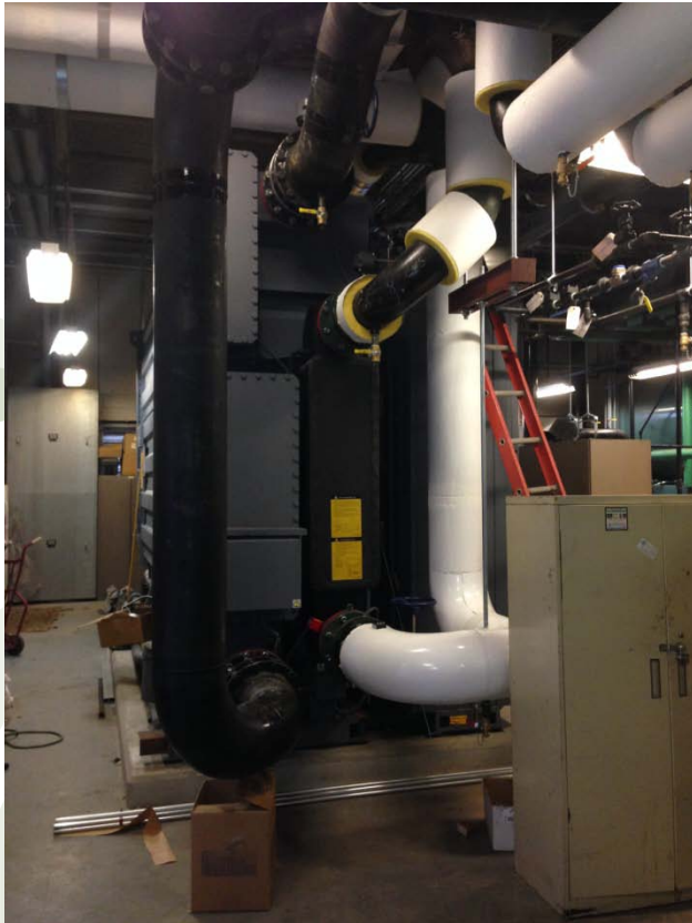
350 Ton Absorption Chiller
